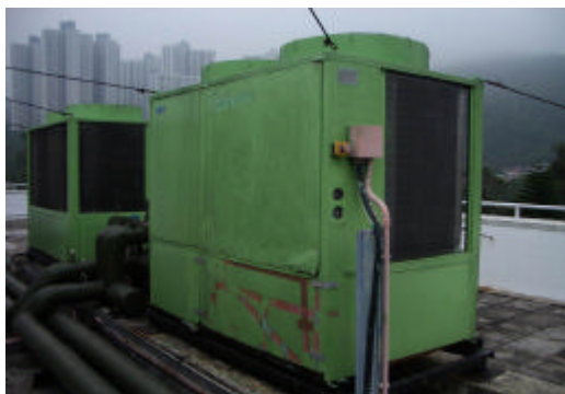
氣冷式冷卻水系統
