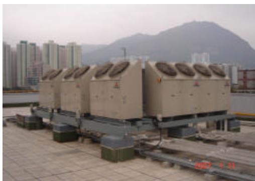
可變冷媒流量空調系統
