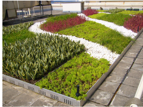
柴灣消防局的天台綠化工程
