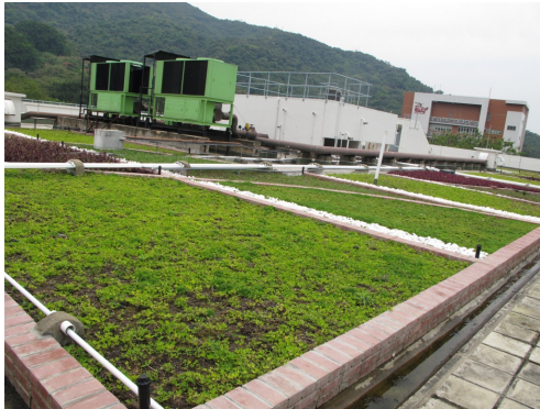
薄扶林消防局的天台綠化工程
