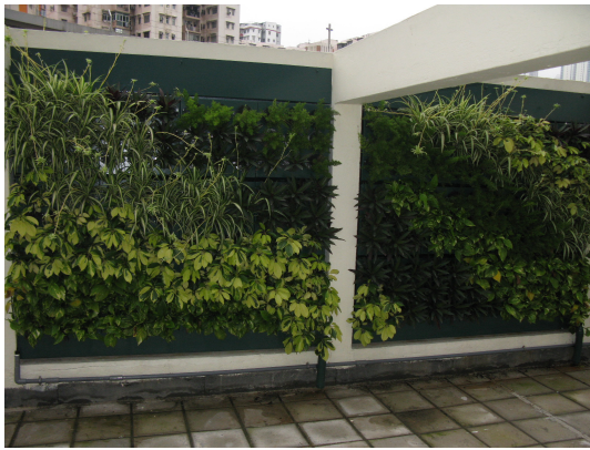
觀塘消防局的天台綠化工程
