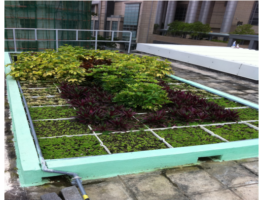
荔枝角消防局的天台綠化工程
