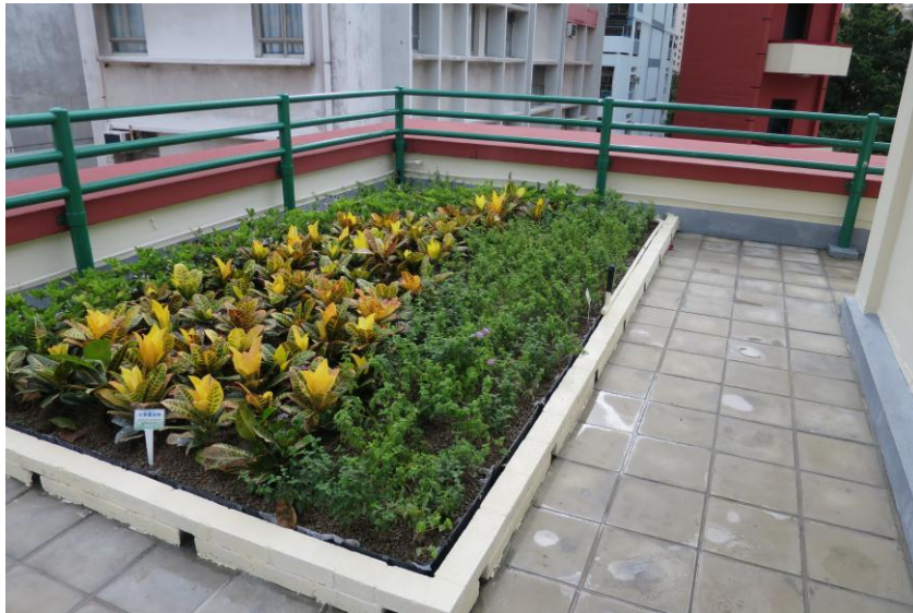
馬頭涌消防局的天台綠化工程 Green Roof at Ma Tau Chung Fire Station
