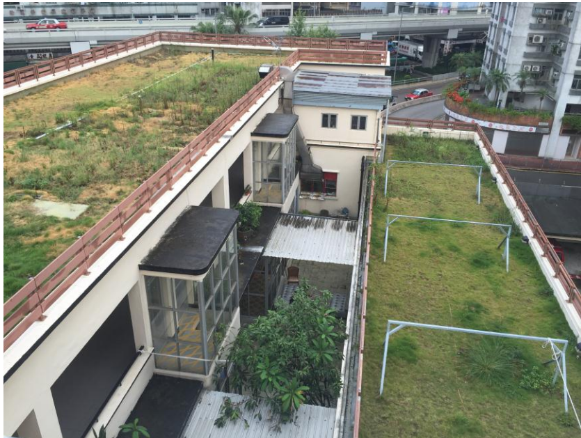
旺角消防局的天台綠化工程 Green Roof at Mong Kok Fire Station
