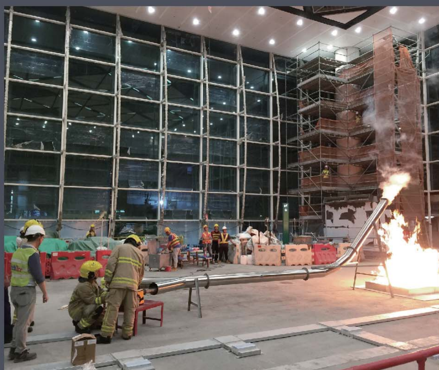
消防人員於一號客運大樓擴建部份進行消防裝置及設備（排煙系統）檢驗工作。
