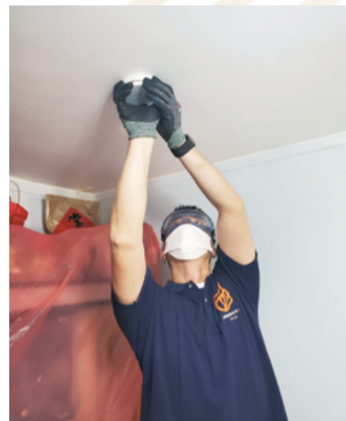
▲ 消防處義工隊為獨居長者安裝獨立火警偵測器。
