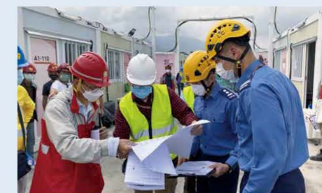
▲抗疫設施驗收專項工作組人員與工程師核對消防裝置及設備圖則。
