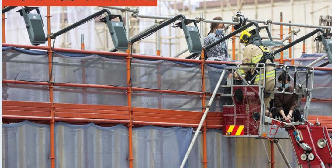
▲消防員在鋼梯車上拯救被困市民。（香港01圖片）
