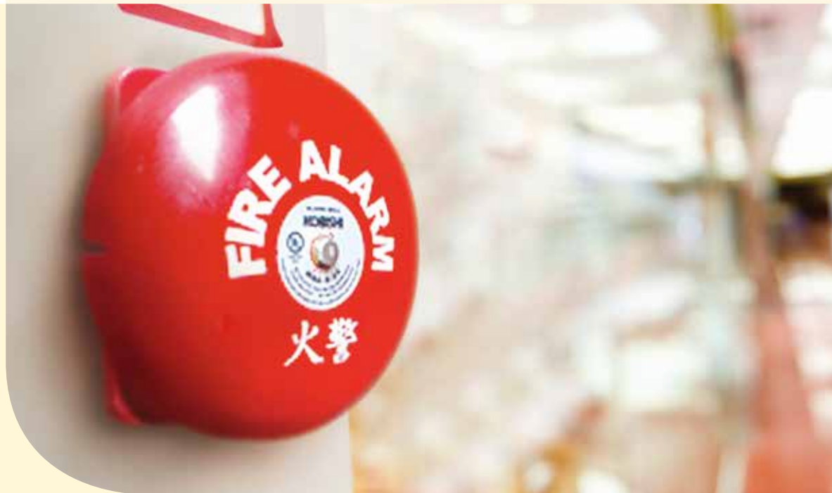
火警警钟。 A fire alarm.
