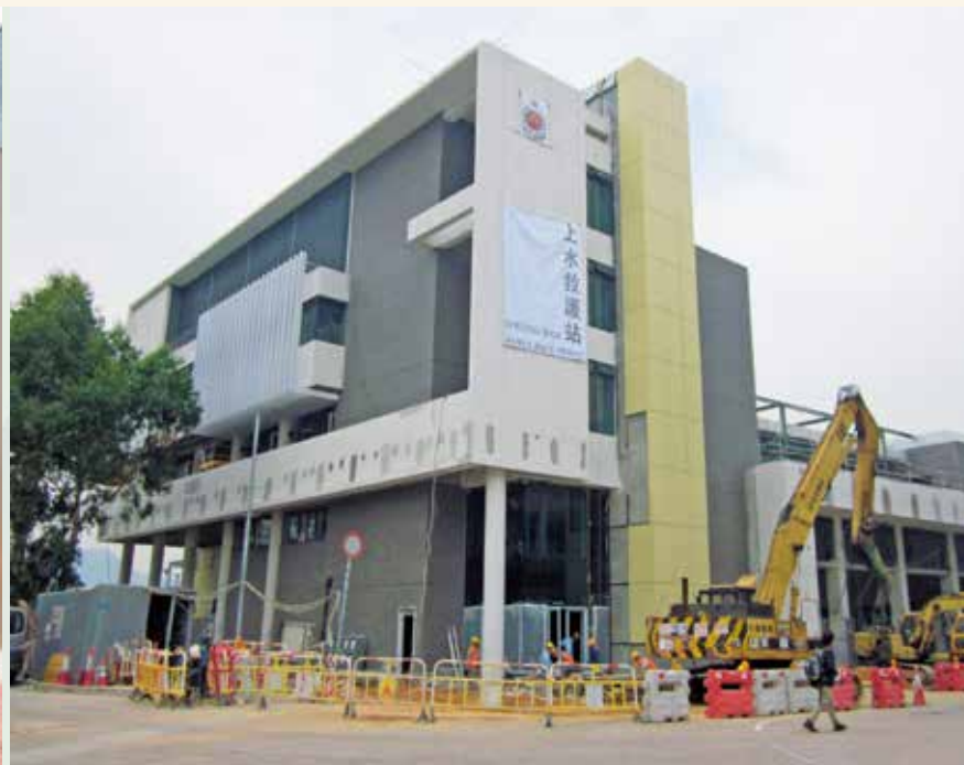
兴建中新上水救护站的照片。
