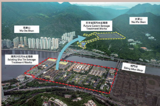
● 位於亞公角女婆山的岩洞污水處理廠，覆蓋岩洞範圍為350米乘400米，將透過兩條隧道連接到路面。
