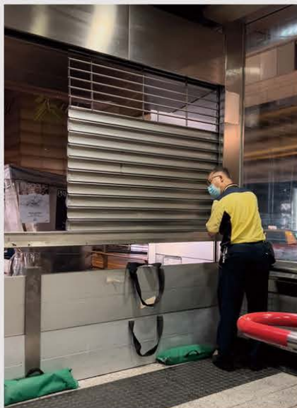
▲ 港鐵公司於出入口加設可拆卸式擋水板及沙包，並會因應情況關閉港鐵站出入口。
