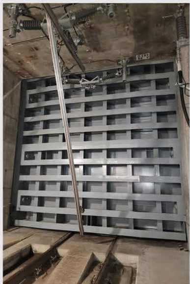
▲ 港鐵公司為應對水浸而於過海段的行車隧道兩端設置防洪閘。
