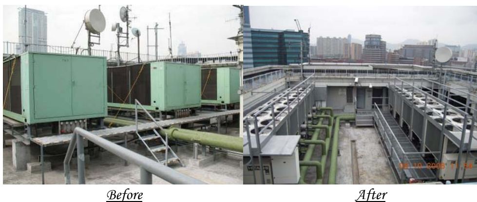
消防處總部大廈更換兩座新用空氣冷卻式水冷系統
