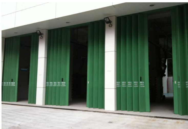
設有變速驅動裝置的救護站摺閘
