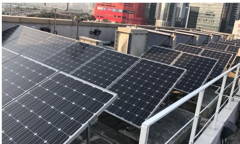
安裝於啟德消防局天台的太陽能電池板
