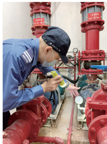
消防設備專責隊伍檢查大廈內的消防裝置及設備，以確保有效操作。
