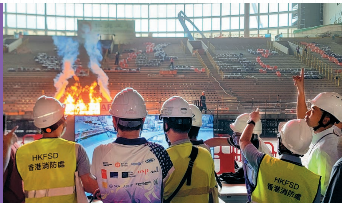
▶消防工程合規人員為啟德體育園主場館的排煙系統進行熱煙測試。
