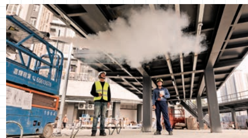
◀部門驗收人員使用製煙機對新建公營房屋項目的煙霧偵測器進行功能性測試。
