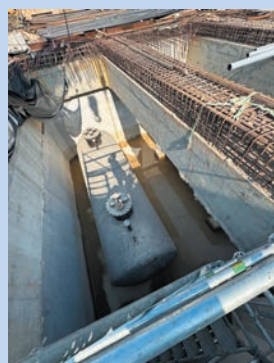
綜合廢物管理設施備有大型地底油缸，為焚化機組供應所需燃料。
