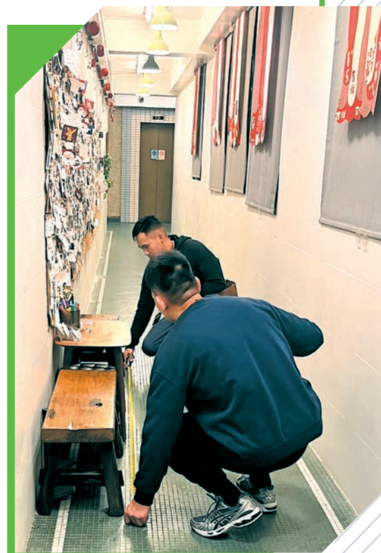
消防人員以便裝突擊巡查有高風險的商業大廈。
