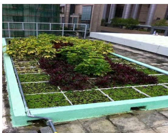
觀塘消防局的綠化天台
