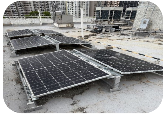
於葵涌消防局安裝的太陽能光伏板
