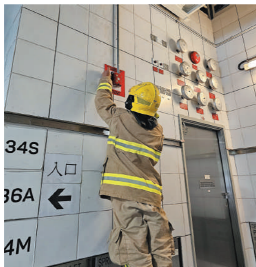
▶消防人員使用「消防員緊急開關掣」作緊急斷電。
