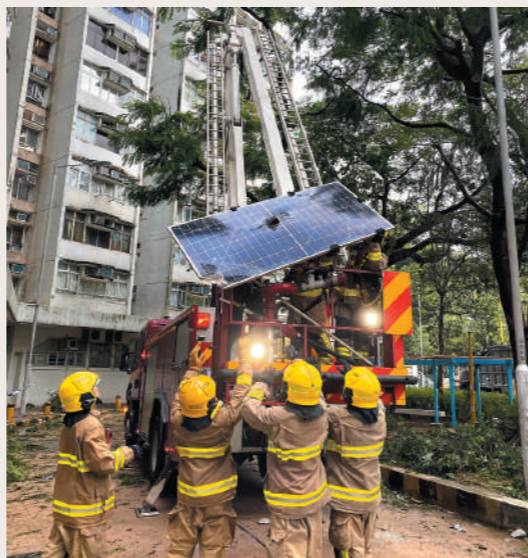
▲人員移除被強風吹至搖搖欲墜的太陽能板。
