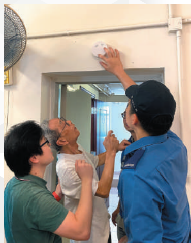
▲消防處人員為村民安裝獨立火警偵測器。
