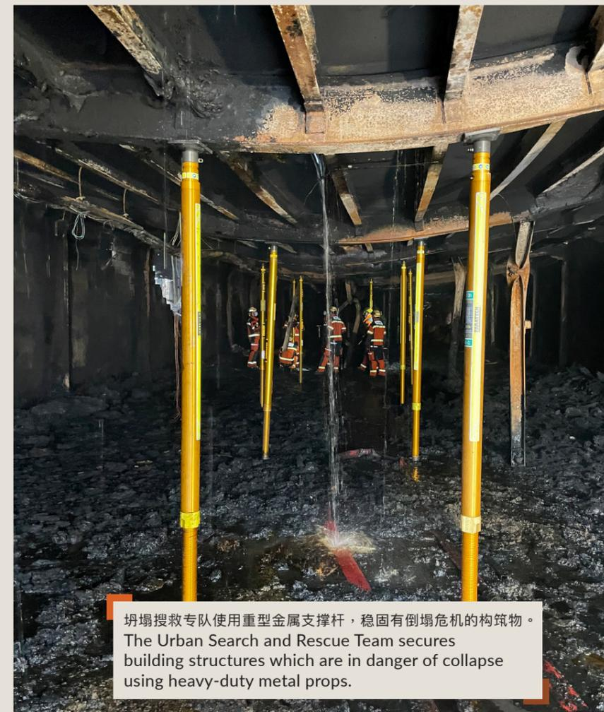
坍塌搜救专队使用重型金属支撑杆，稳固有倒塌危机的构筑物。
