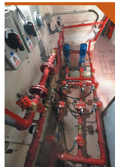
▲折衷式喉轆系統（直接泵水設計）
