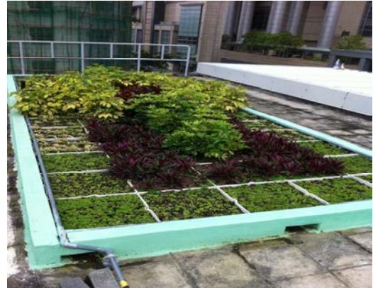
荔枝角消防局的天台綠化工程
