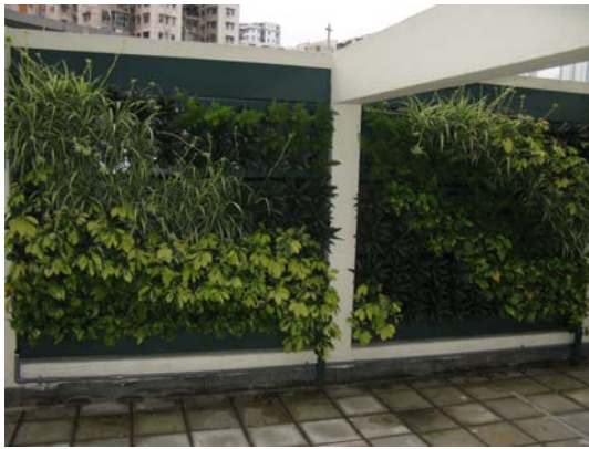
觀塘消防局的天台綠化工程
