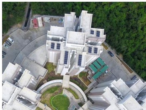
于宿舍范围内安装的太阳能光伏板
