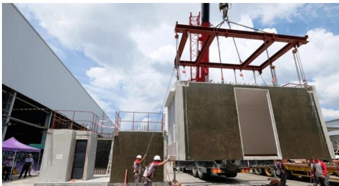
消防处百胜角已婚人员宿舍采用「组装合成」建筑法
