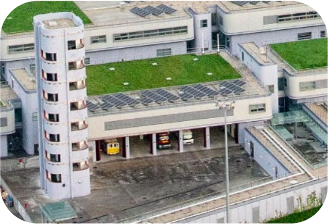
港珠澳大桥消防局暨救护站
