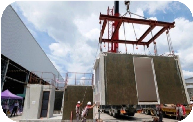
消防处百胜角已婚人员宿舍采用「组装合成」建筑法
