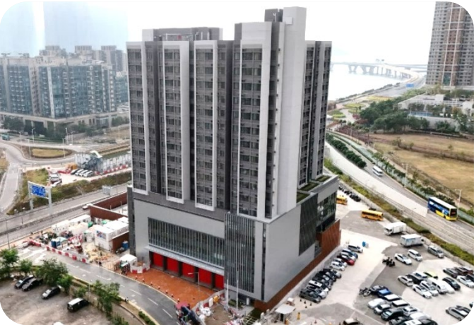
位于将军澳第 72 区现正兴建中的的部门宿舍单位及相关设施采用「组装合成」建筑法
