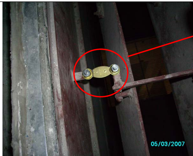
以消防處認可的保險連杆連接的防火閘
